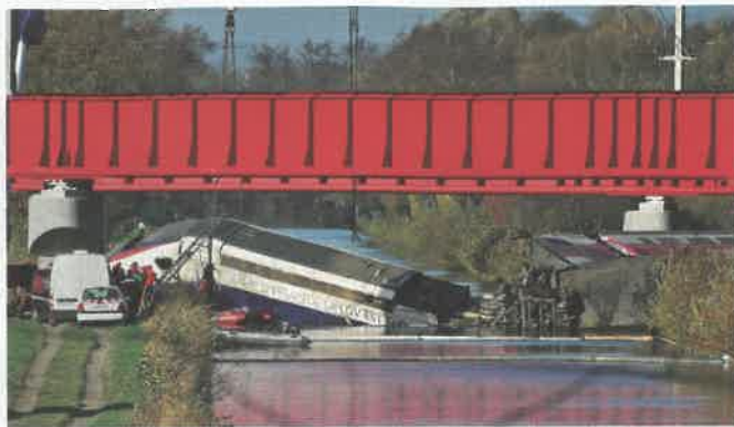
Motrice TGV Dasye 29787 et voitures 291744 et 292744 partiellement immergées dans le canal de la Marne au Rhin après le déraillement d'Eckwersheim.
