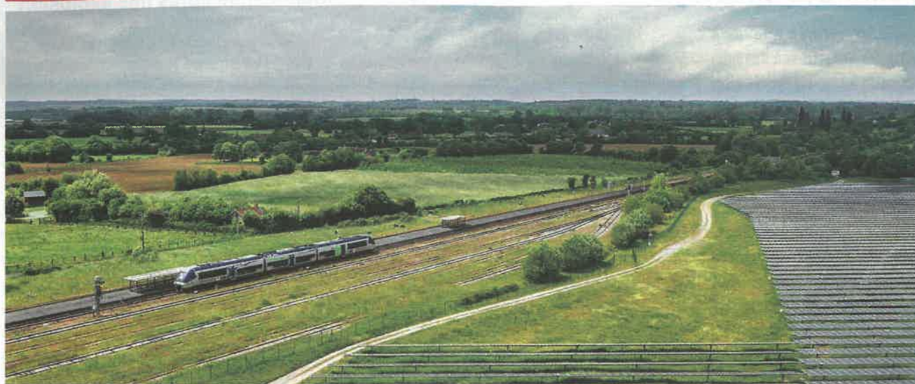
Une ferme photovoltaïque de 17 hectare a été installée en 2018 sur un ancien site ferroviaire, près de la gare de Surdon dans l'Orne.
