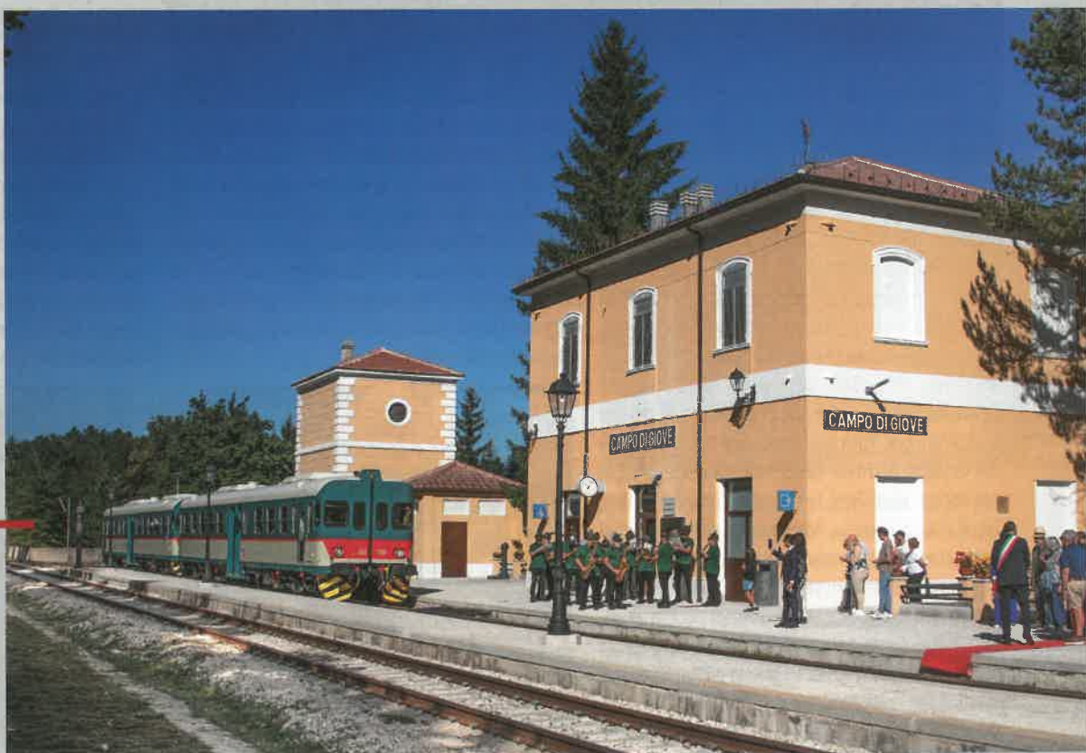
Dopo il treno inaugurale della scorsa primavera tra Ancona, Fabriano e Pergola, le ALN 668.3319 e 3308 trasformate per l'alimentazione a bioGNL, hanno percorso per la prima volta la linea Sulmona-Isernia raggiungendo la stazione di Campo di Giove (13 settembre, foto G. Bartimoccia).
