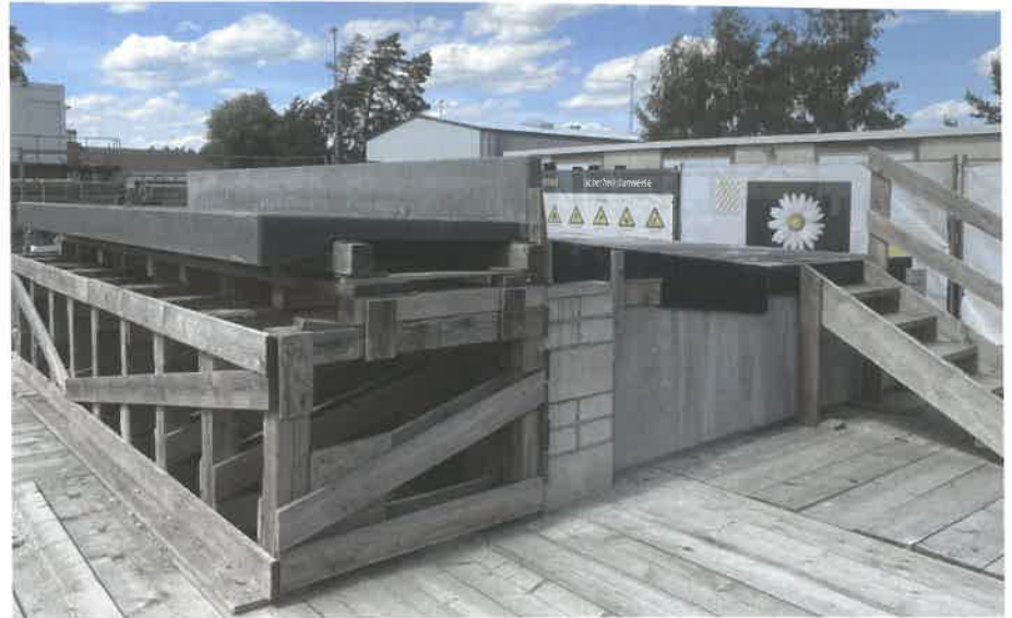
Abb. 1: Fertiggestellte UHFB-Fertigteilkappe auf der Nachbildung einer Gewölbebrücke
