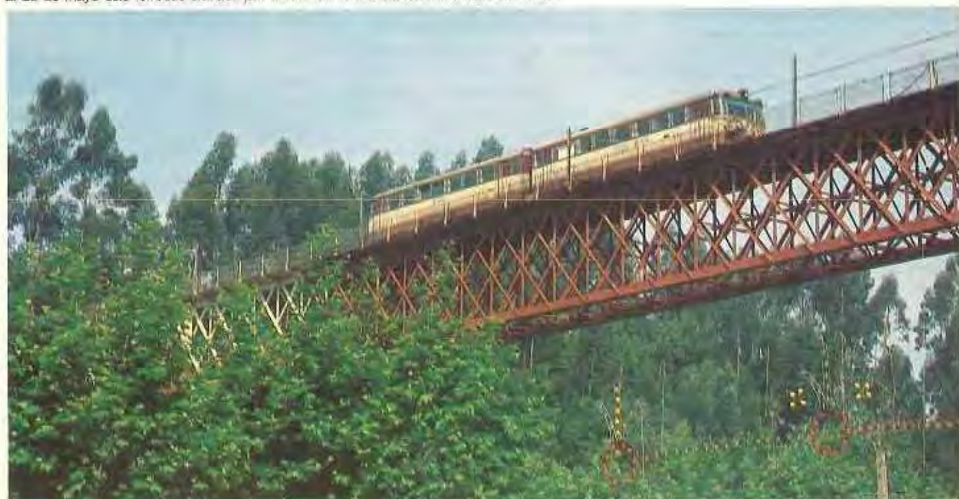
El 28 de mayo este ferrobús cruzaba por última vez el viaducto metálico de Redondela.
