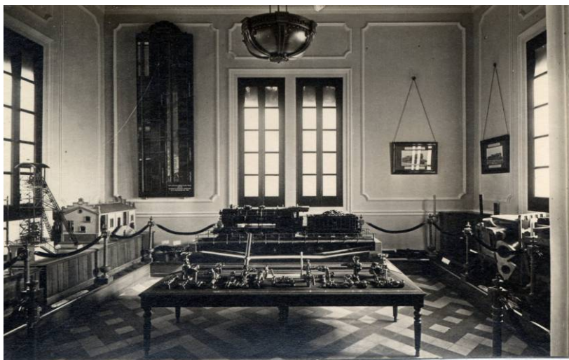
Interior del Pabellón. Instalaciones del Servicio de Material y Tracción. Fuente: AHF C-1447-001/28.
