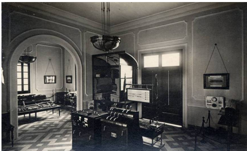
Interior del Pabellón. Instalaciones del Servicio de Eléctrico. Fuente: AHF C-1447-001/28
