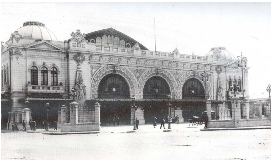
Fig. 3.- Edificio de la Estación Mapocho. Santiago de Chile. Moraga. (2001) p84
