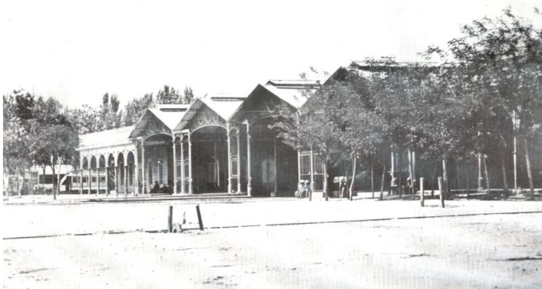
Fig. 1.- Antiguo edificio de la Estación Central. Santiago de Chile. Moraga. (2001) p.92
