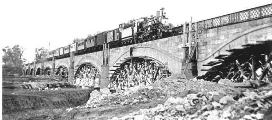
Locomotora serie 230-4017 (ex M.Z.A. 667), con un tren formado por un furgón con garita de M.Z.A., un vagón jaula de dos pisos, cuatro coches de dos ejes con balconcillos abiertos, un vagón postal, dos coches de dos ejes de pasillo lateral parcial y un furgón con garita, cruzando el nuevo puente sobre el río Aljucén (1927) Juan Salgado Lancho [M.Z.A._0241-IF_10-20]
