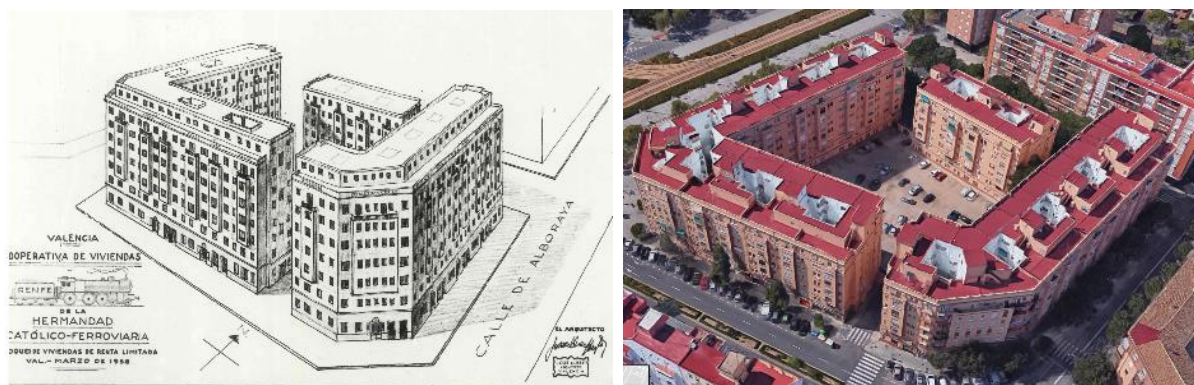
Ilustración 2. Vista general de los edificios de la cooperativa de viviendas de la Hermandad Católico-Ferroviana de Valencia construidos en 1956. Dibujo de proyecto y estado actual.
