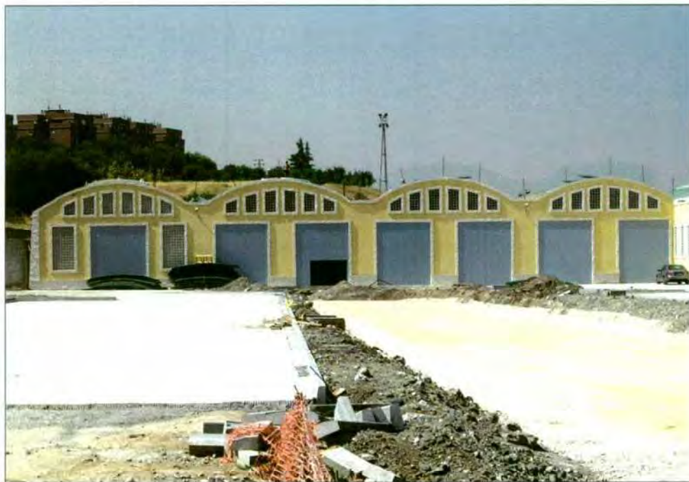
Las nuevas instalaciones respetan parte de las fachadas de los antiguos talleres.
