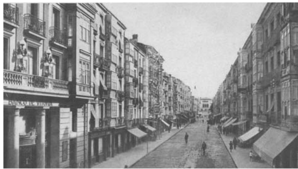
Vitoria, estación y calle de Eduardo Dato
