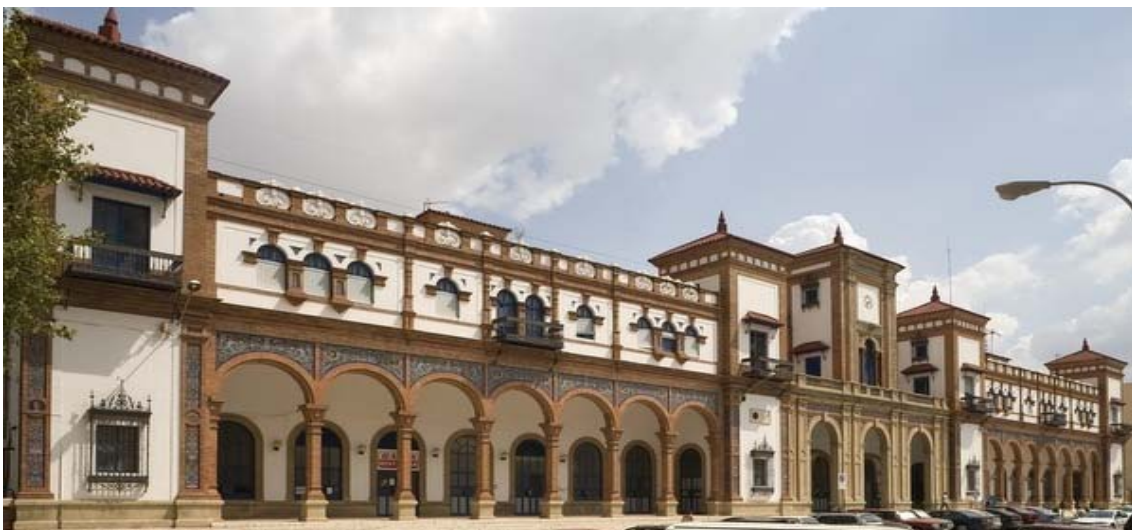
Actual edificio de viajeros de Jerez de la Frontera. Fuente: AHF.
