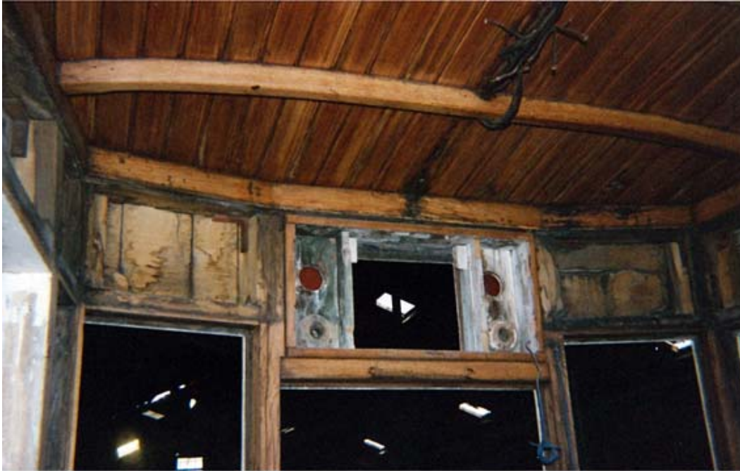
FIG.6- Puesto de conducción del tranvía motor 216 antes de su restauración / Fot. L. Vañó.
