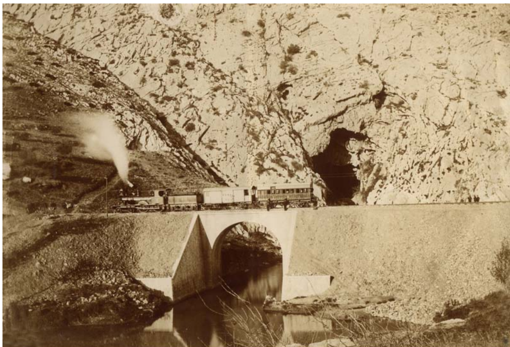
Construcción del ferrocarril Bobadilla-Algeciras junto a la cueva del Gato (1892)
