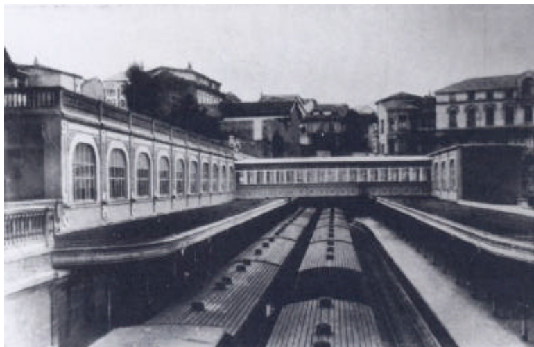
Ilustración 8. Estación de Oviedo. Fachada y pasarelas a los andenes de salida. Archivo fotográfico RIDEA.
